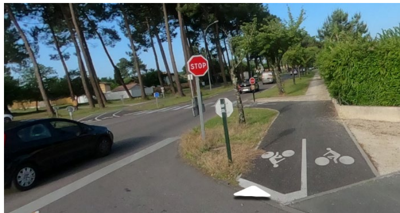
Gujan-Mestras, traversée de l'Allée de Bordeaux pour un changement du côté de la Vélodyssée (les 2 photos du haut) et traversée de l'allée Brémontier quand on vient du Teich (ou inversement dans l'autre sens) (street-view google maps en bas).
